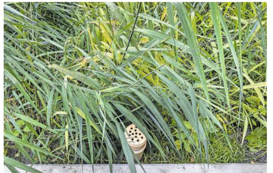
Eine Pumpe übernimmt die Verteilung auf dem Schilffeld – heraus fliesst klares Wasser.
