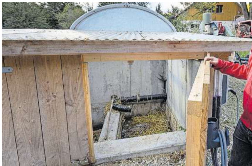
Fäkalien und Feststoffe bleiben hier zurück, das Wasser fliesst weiter in einen Tank.
