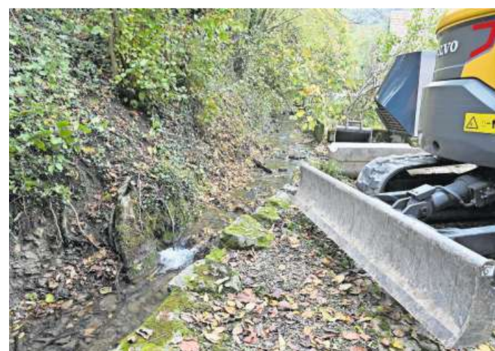
Die Bagger sind beim Lostorferbach aufgefahren. Bild: Bruno Kissling
