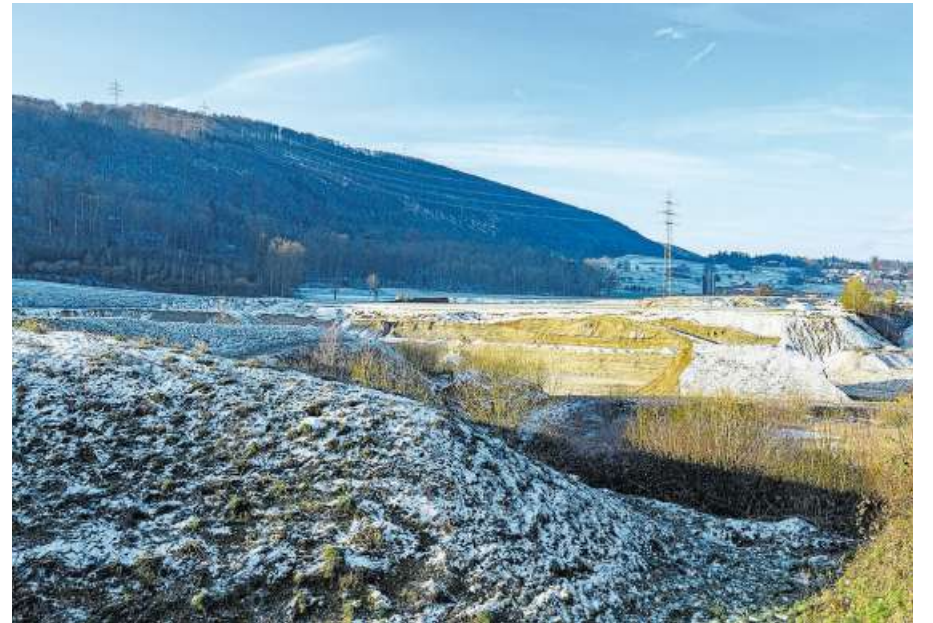
Bahnanschluss, Installationsplätze, Tunnelbau und eine bleibende Schachanlage: Hier im Gebiet Hard hat Cargo Sous Terrain Grosses vor. Bild: Bruno Kissling
