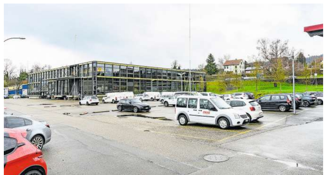
«Dynamik in die Region bringen»: Hier, zwischen Bahnlinie und Niederämterstrasse, plant die Varia Swiss Realtech Properties AG den Erweiterungsbaau.
