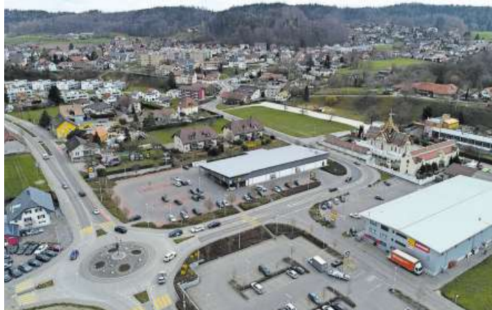
In Gretzenbach ist die Installation von Mobilfunkantennen ein sensibles Thema. Bild: Bruno Kissling
